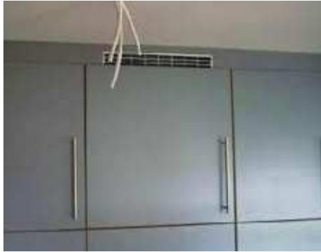
Lüftungsgitter im Oberschrank
