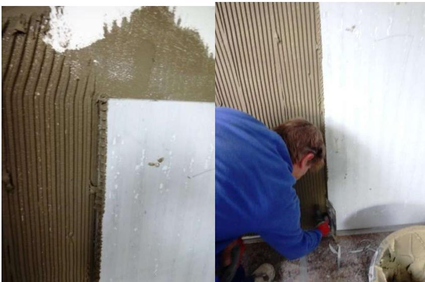
Man erkennt, dass die Fugen sehr dünn gehalten werden müssen (ca. 2 mm)
