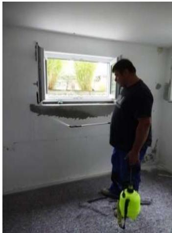
Grundierung (ggf. mit Wasser verdünnen 1:5) auf die Wand streichen oder sprühen, damit der Spezialkleber sich besser in die Wand verkralen kann. Nach dem Grundieren ist **keine Wartezeit** nötig. *Hinweis Grundierung ganz unten beachten!*
