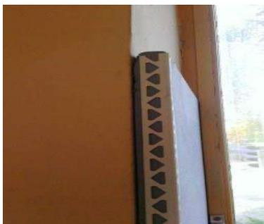
**Rolladengurtführung** mit doppelter Bürstendichtung gg. Zugluft;
