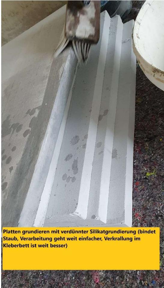
Platten grundieren mit verdünnter Silikatgrundierung (bindet Staub, Verarbeitung geht weit einfacher, Verkrallung im Kleberbett ist weit besser)
