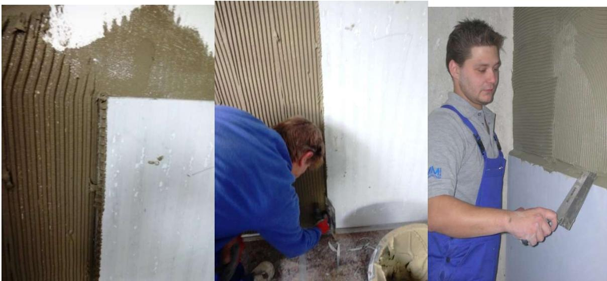
Man erkennt, dass die Fugen sehr dünn gehalten werden müssen (ca. 2 mm)
