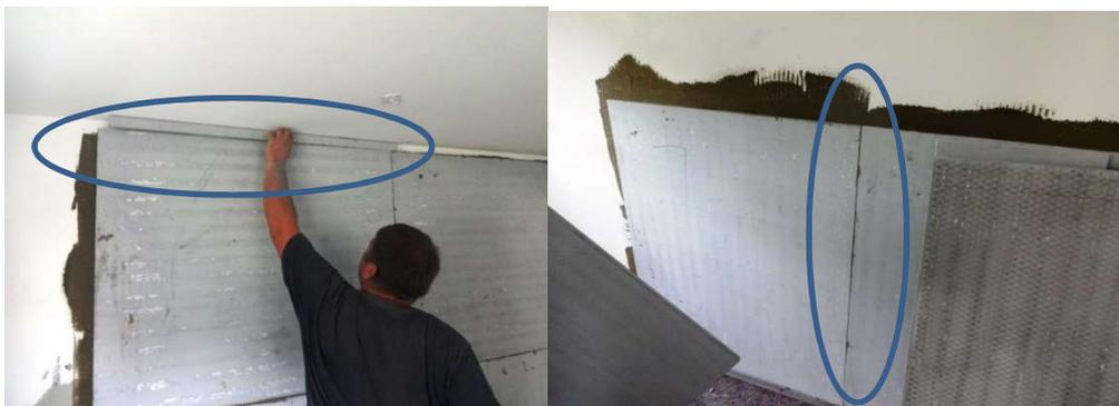
Man schneidet sich ggf. die Platte zu, so dass die gesamte Wandfläche saniert wird.
