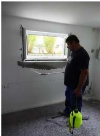
Passende Grundierung (ggf. mit Wasser verdünnen 1:5; bei Gipsputz: Spezialgrundierung) auf die Wand streichen oder sprühen, damit der Spezialkleber sich besser in die Wand verkrallen kann. Nach dem Grundieren ist **keine Wartezeit** nötig. *Hinweis Grundierung ganz unten beachten! Wichtig!*
