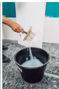
Die verklebten Platten mit verdünnter Silikatgrundierung befeuchten - dann lässt es sich kinderleicht verspachteln!
